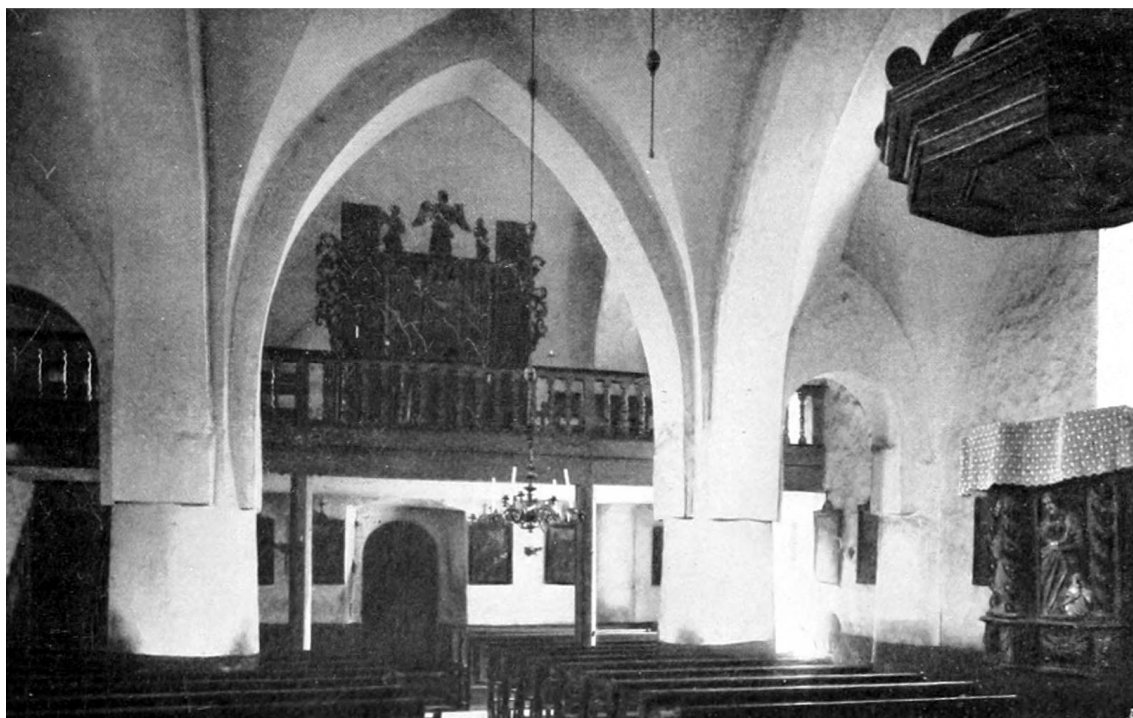
Heggen: Speith/Rieschick-Organ kurz vor dem Abbruch
